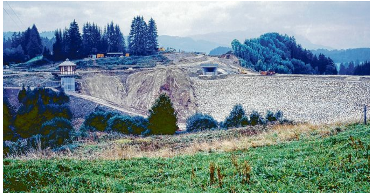
Anfang der 80er Jahre wurde mit dem Bau des Rottachspeichers im Oberallgäu begonnen. Das Foto entstand im September 1988 und zeigt den in Arbeit befindlichen Staudamm.
