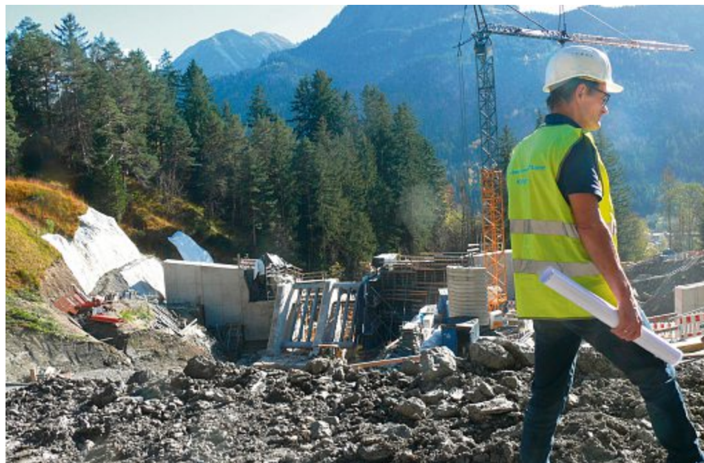
Vom Dorf aus ist die Großbaustelle nicht auszumachen, nur von oben erkennt man die Dimensionen der neuen Murschutzsperre bei Vorderhindelang
