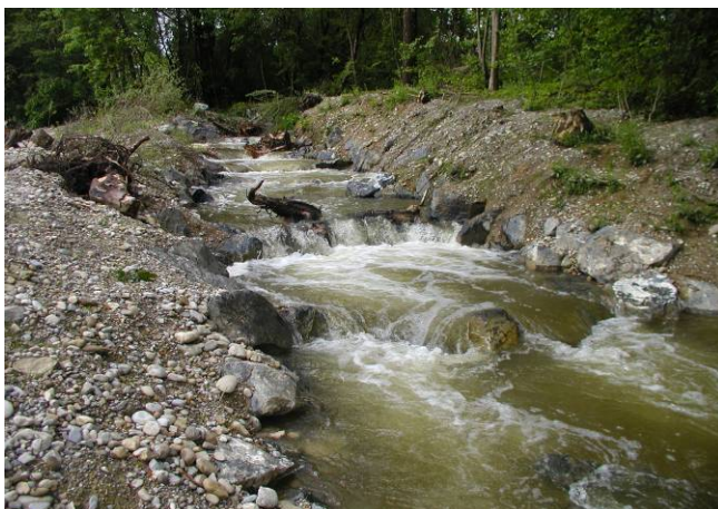
Fischpass / Becken im unteren Bereich
