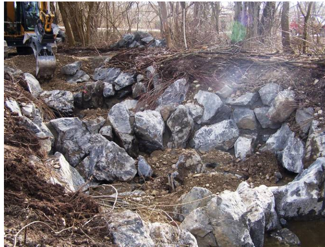
Bau der Becken
