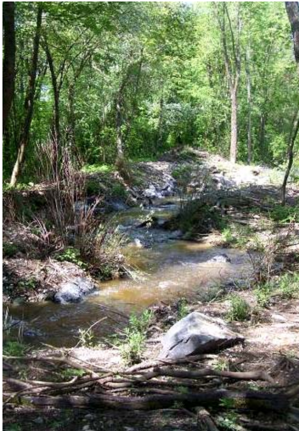
Freie Fließstrecke des Fischpasses im mittleren Bereich
