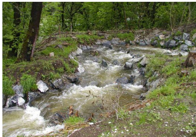
Fischpass / Becken im oberen Bereich
