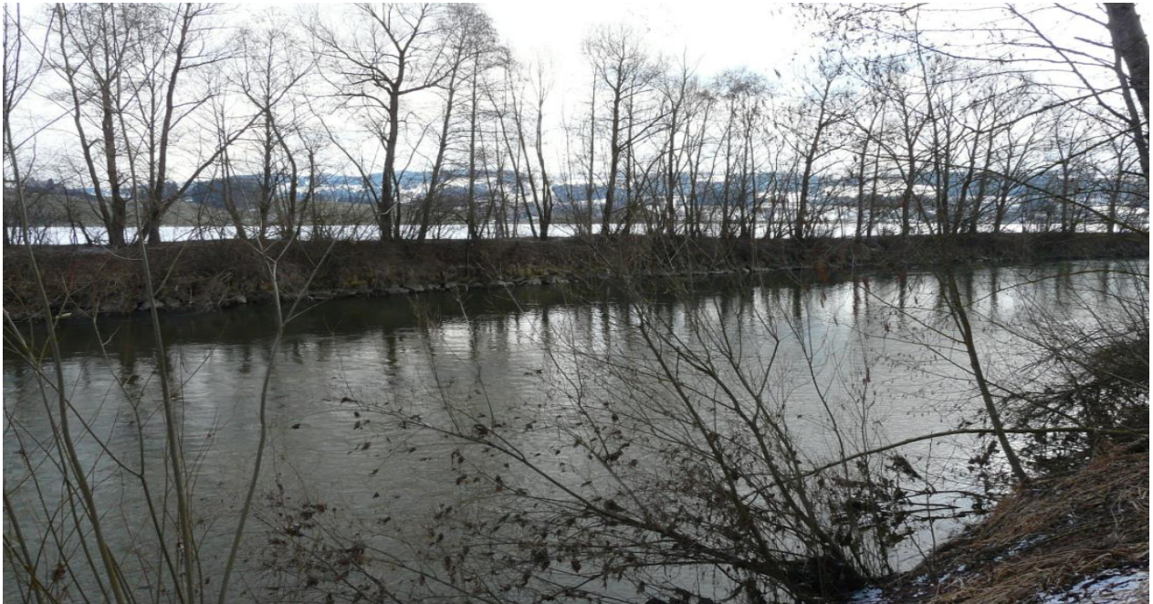
Abb.1: Ist-Situation im Sulzberger Becken: begradigter Flusslauf mit befestigten Ufern und nur einzeiligem Uferbewuchs (Foto: WWA KE)
