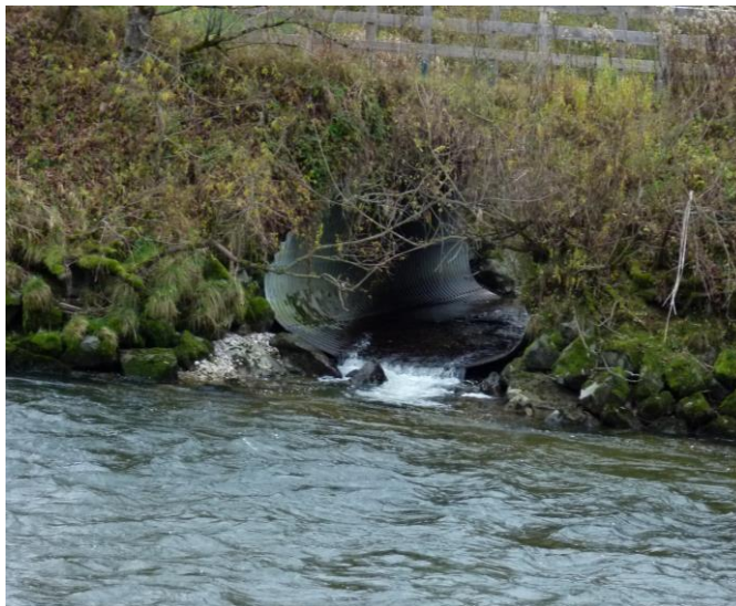
Abb.8: Altwasser-Anschluss bei Fkm 94 ohne Rückstauklappe Abb.9: Bessere Anbindung Kollerbach bei Fkm 95,4.
