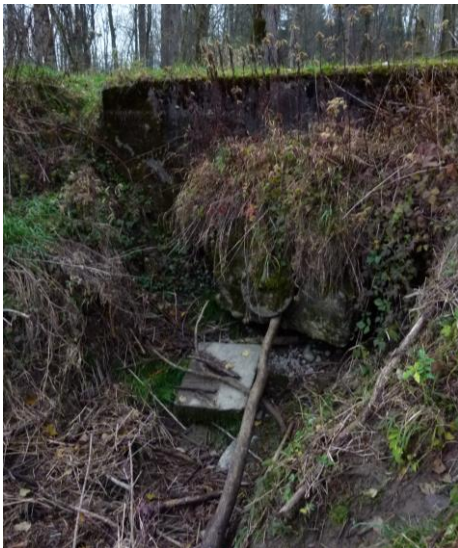
Abb.8: Altwasser-Anschluss bei Fkm 94 ohne Rückstauklappe Abb.9: Bessere Anbindung Kollerbach bei Fkm 95,4.
