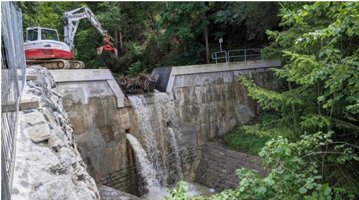
*Abbildung 3: Voll gefüllte Geschiebe- und Schwemmholtzsperr im Oberlauf des Dorfbachs am Tag nach dem Hochwasser vom 26.07.2021 bei Baggerräumung des Netzes (Quelle: Wasserwirtschaftsamt Kempten).*
